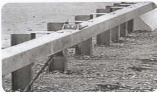
รูปที่ ๕ การติดตั้งราวกันอันตรายแบบกล่องข้างทาง
