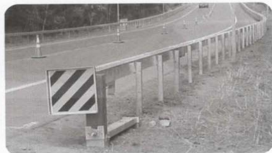
รูปที่ ๕ การติดตั้งราวกันอันตรายแบบกล่องข้างทาง
